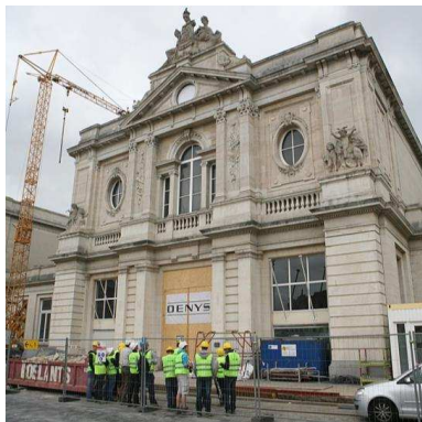
Renovatie van het stationsgebouw
