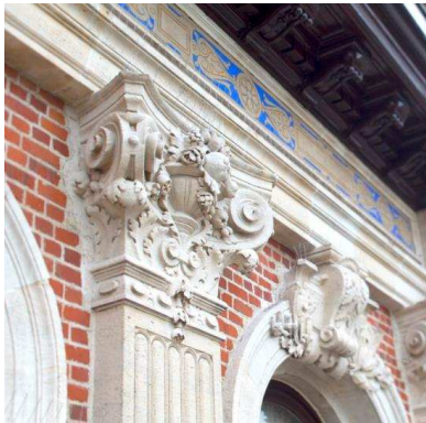
Restauratie- en verbouwingswerken
