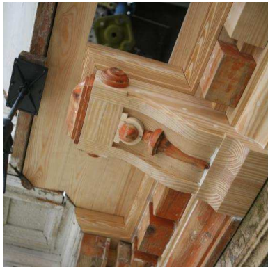
Restauratie- en verbouwingswerken
